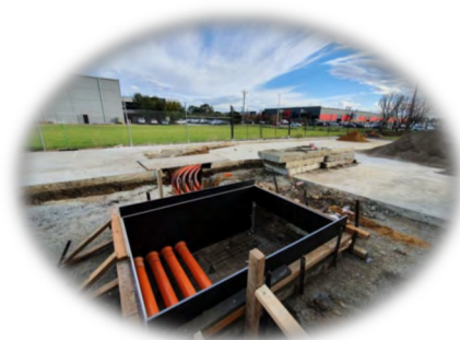
Slab formed & ready for concrete pour
